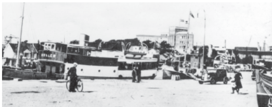
Her ligger "Hvaler", med nyinstallert dieselmotor, ved kai i Fredrikstad FMV-bygge- sees i bakgrunnen. Overbygget har fått runde ventiler og skorstenen er malt gul. DSet skjedd etter styrevedtak i 1949. Alle selskapets fartøyer med dieselmotor skulle ha gul skorsten. Bildet er tatt våren 1949 eller 1950.
