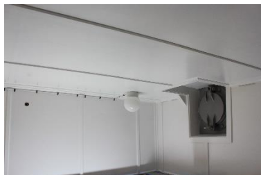
Tidsriktige kupler, egenproduserte kabel-klips og dyse vanntåkeanlegg
