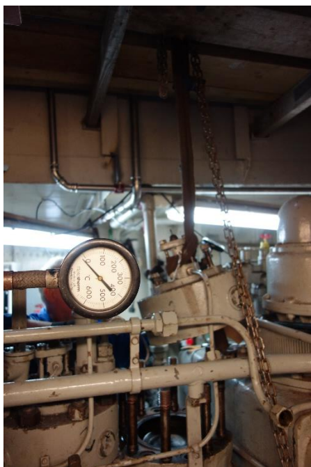
Temperaturmåler for hoveddeksos
