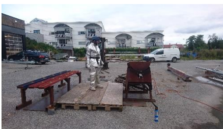
Støping av blokker i former
