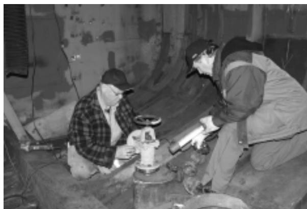
Ole Jelstad og Terje Haraldsen monterer ny bunnventil. Foto: Tor W. Eriksen
